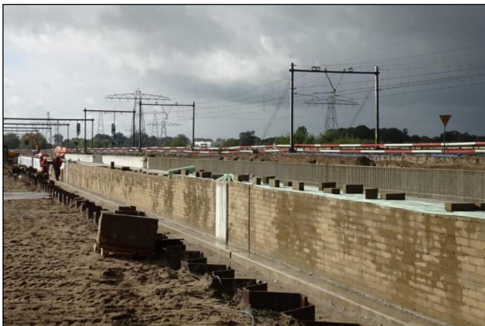
Ilustración 15. Ejemplo de una barrera acústica construida con sedimentos excavados en la construcción de un túnel de ferrocarril. Fuente: Geowall en Deltares, jornadas Sediment Management, 2021
